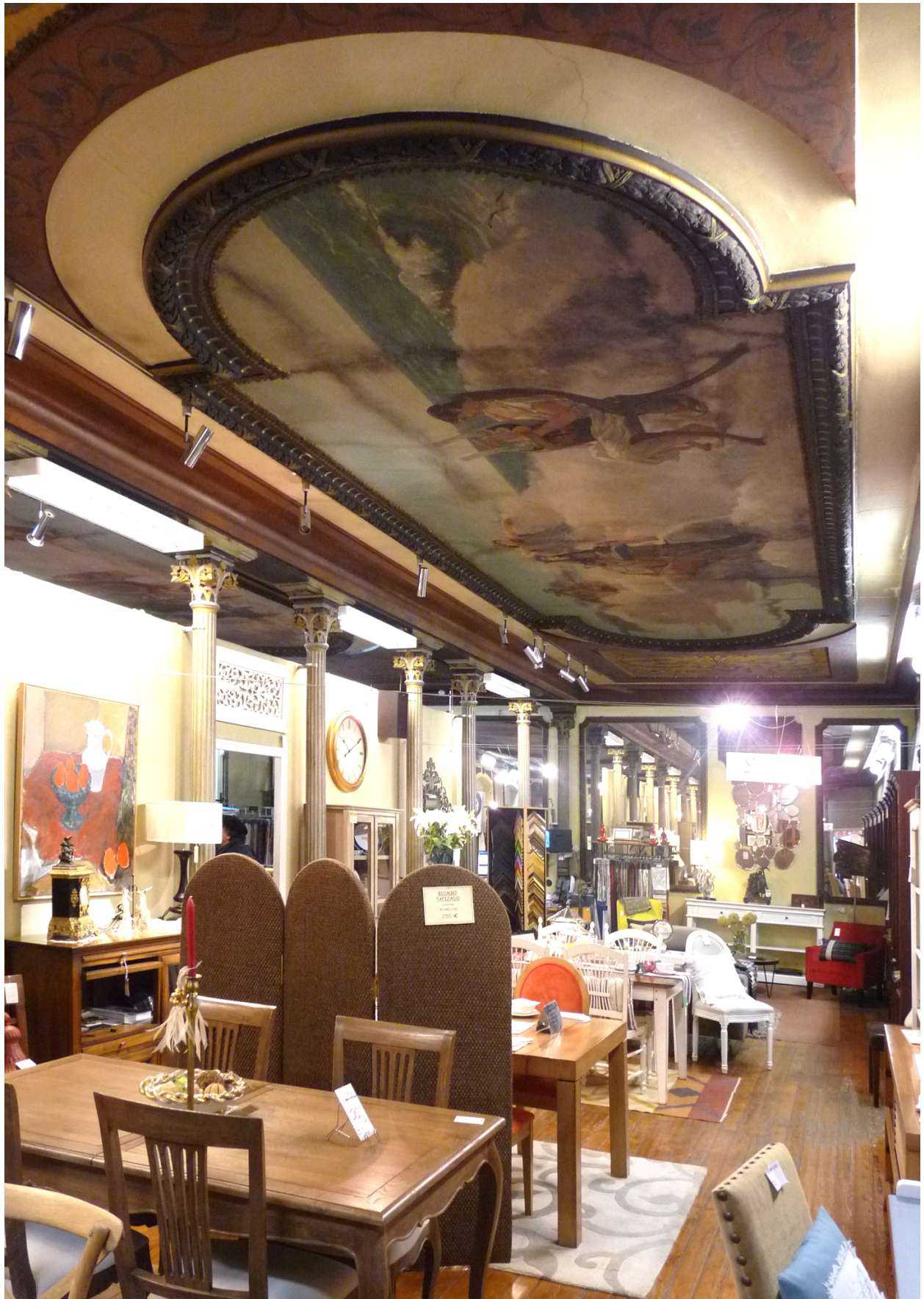
Vista general de la crujía interior del Sal6n Montano, paralela a la calle de Dos Amigos, con la alegoría de La Músca en la Antigüedad , decorando el techo. Al fondo, el testero con espejos que servía de escenario, y a la izquierda la hilera de columnillas de fundición que partía en dos naves este espacio. Fotografía: VPAT.
