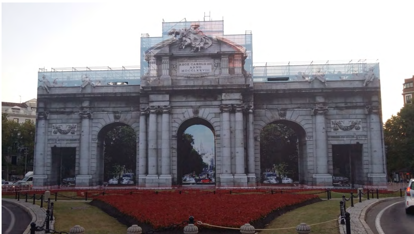
Fig. 184- VPAT: La Puerta de Alcalá el 26 de julio de 2022, revestida por las lonas que la cubrirán durante los trabajos de toma de datos y restauración, y que reproducen la propia Puerta..
