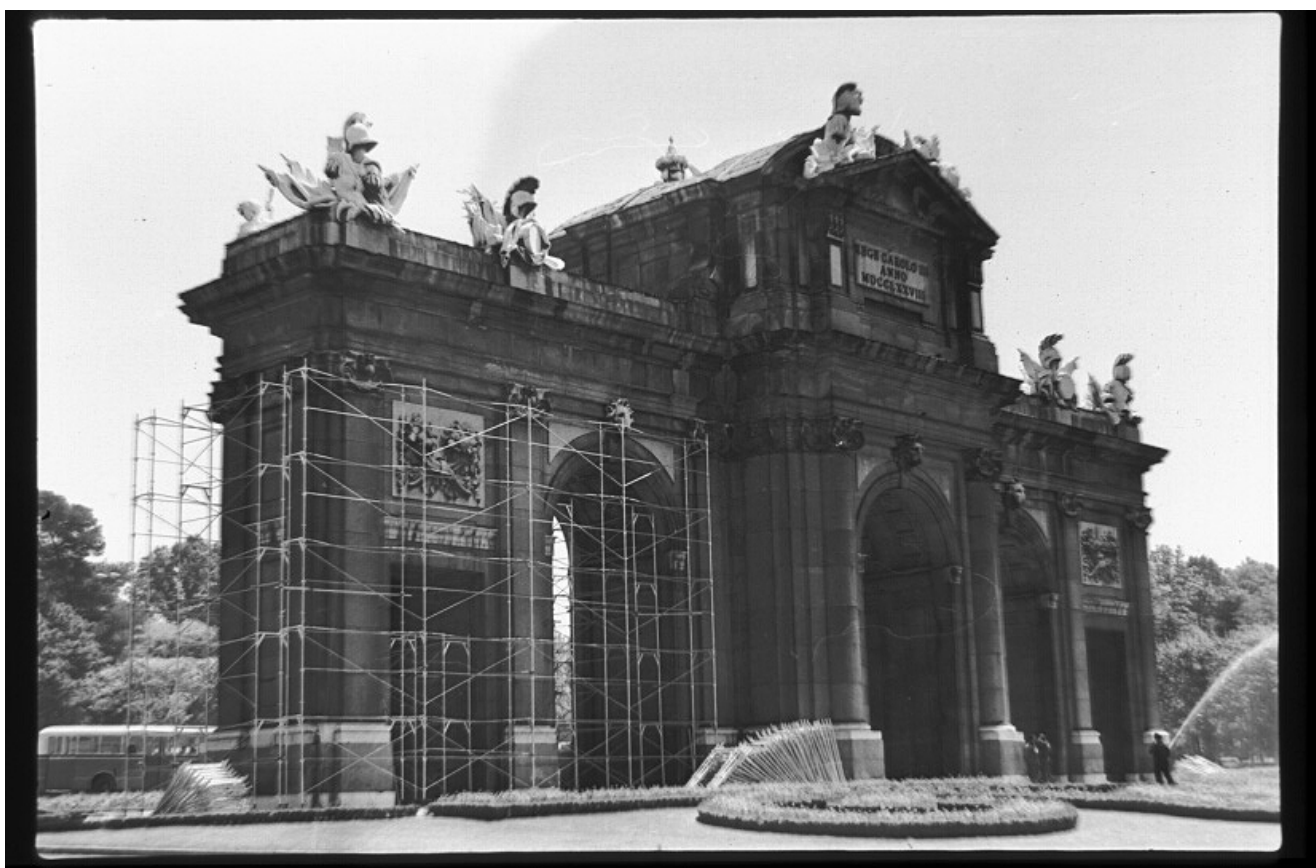
Fig. 170- Martín Santos Yubero. La Puerta de Alcalá siendo andamiada para someterla a limpieza , 9 de mayo de 1973. Archivo Regional de la Comunidad de Madrid.
