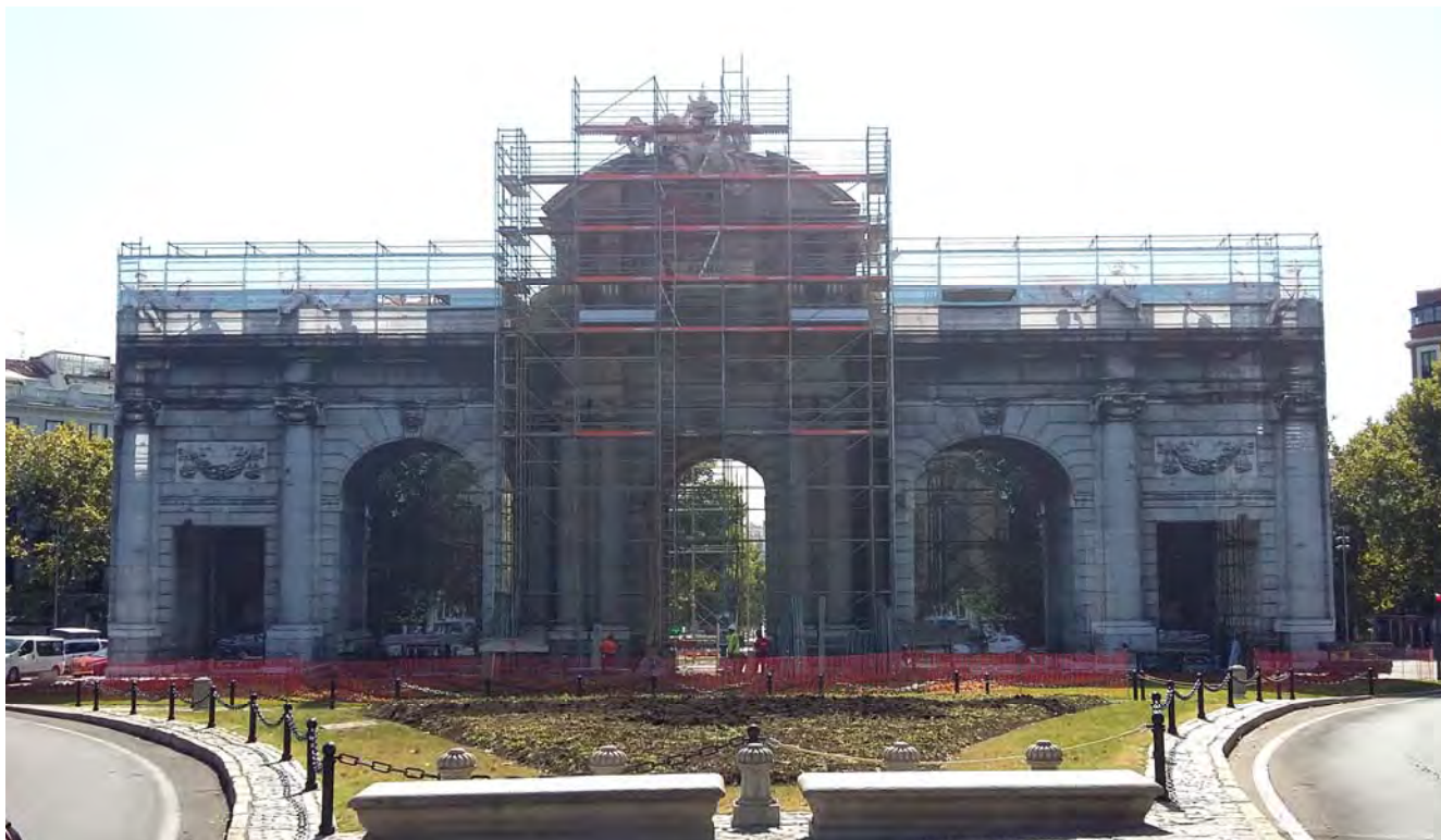
Fig. 183- VPAT: La Puerta de Alcalá el 22 de julio de 2022, en el momento de instalarse las lonas que cubrirán el andamio durante los trabajos de toma de datos y restauración.
