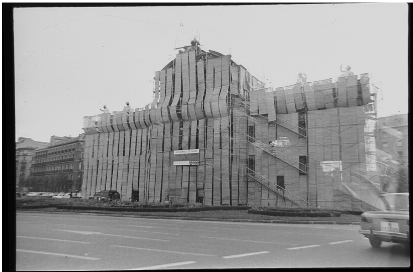
Fig. 171- Martín Santos Yubero. La Puerta de Alcalá cubierta para ser limpiada , 25 de mayo de 1973. Archivo Regional de la Comunidad de Madrid.
