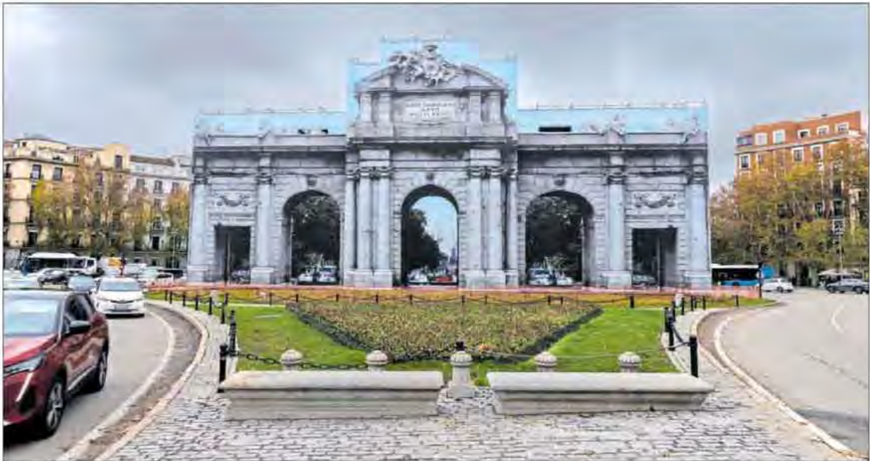
La Puerta de Alcalá con andamios para su rehabilitación, ayer. / MOGI ALTIRAI
