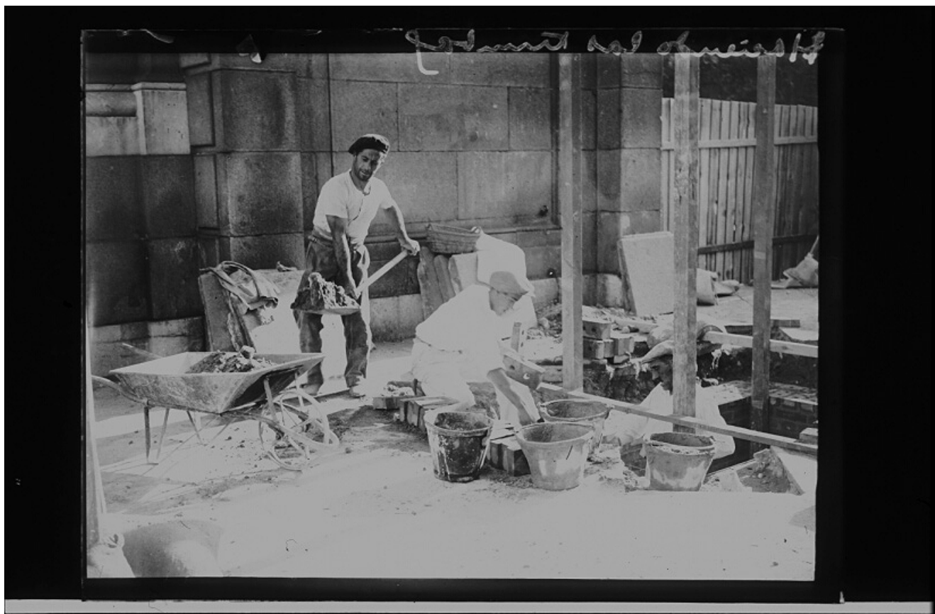
Fig. 223- Martín Santos Yubero: Operarios excavando la fosa para acoger los restos de Galán y García Hernández bajo el arco central de la Puerta de Alcalá, 10 de septiembre de 1934. Archivo Regional de la Comunidad de Madrid.
