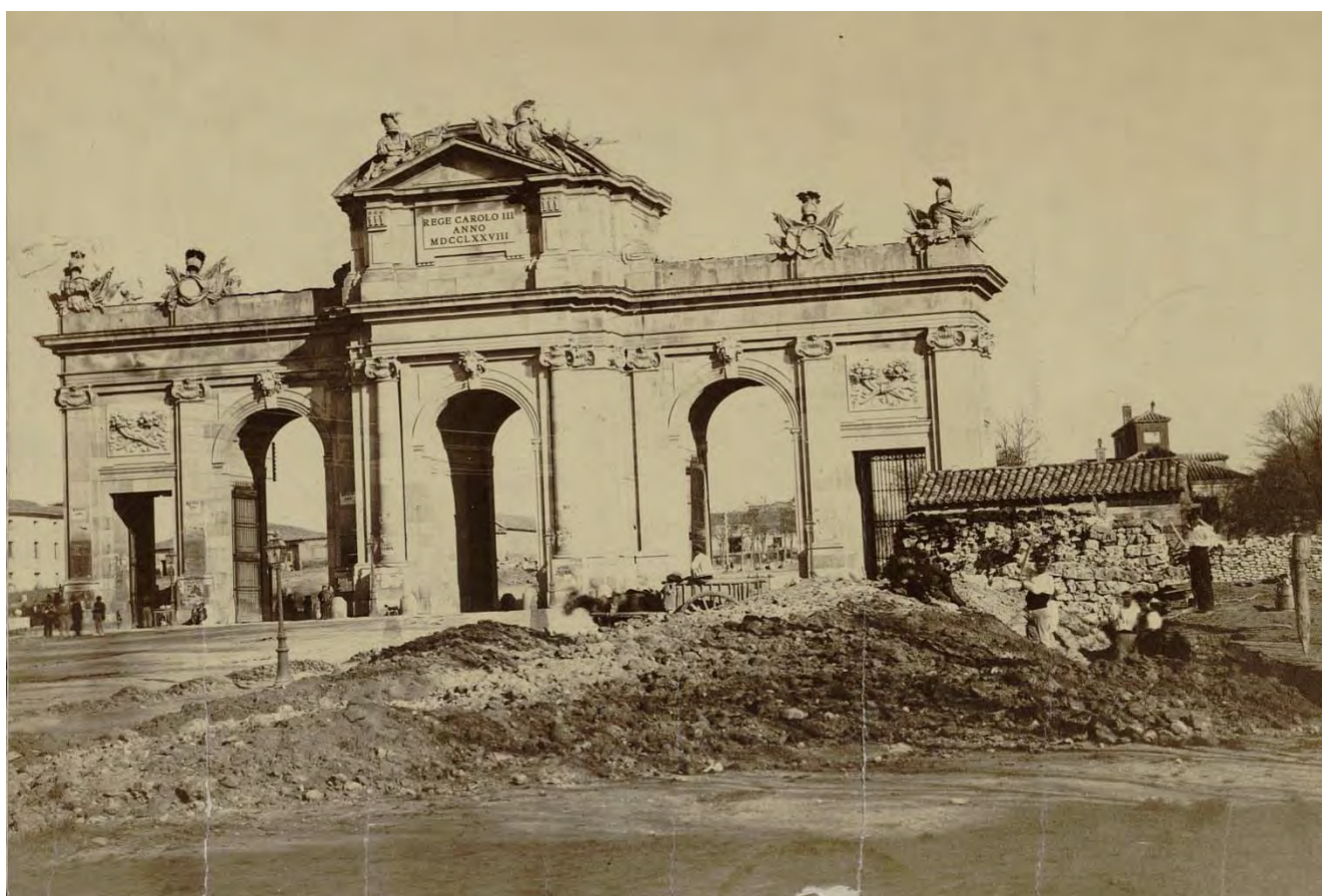
Fig. 61- Anónimo: Obras de construcción de la plaza de la Independencia en torno a la Puerta de Alcalá, h. 1868. Archivo de Villa de Madrid. Todavía pueden verse las rejas de forja que cerraban los pasos por la noche.
