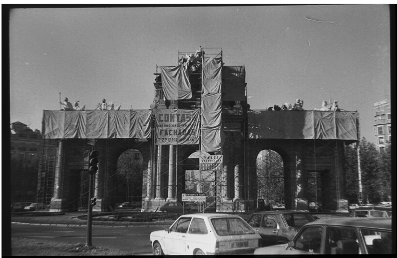
Fig. 173- Martín Santos Yubero. La Puerta de Alcalá rodeada de andamios para ser restaurada , 1 de diciembre de 1979. Archivo Regional de la Comunidad de Madrid.
