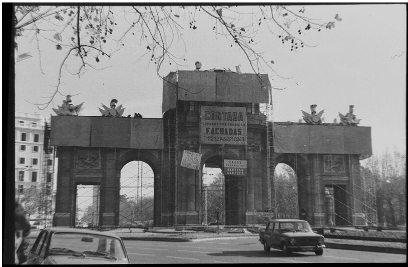
Fig. 174- Martín Santos Yubero. La Puerta de Alcalá rodeada de andamios para ser restaurada , 1 de diciembre de 1979. Archivo Regional de la Comunidad de Madrid.
