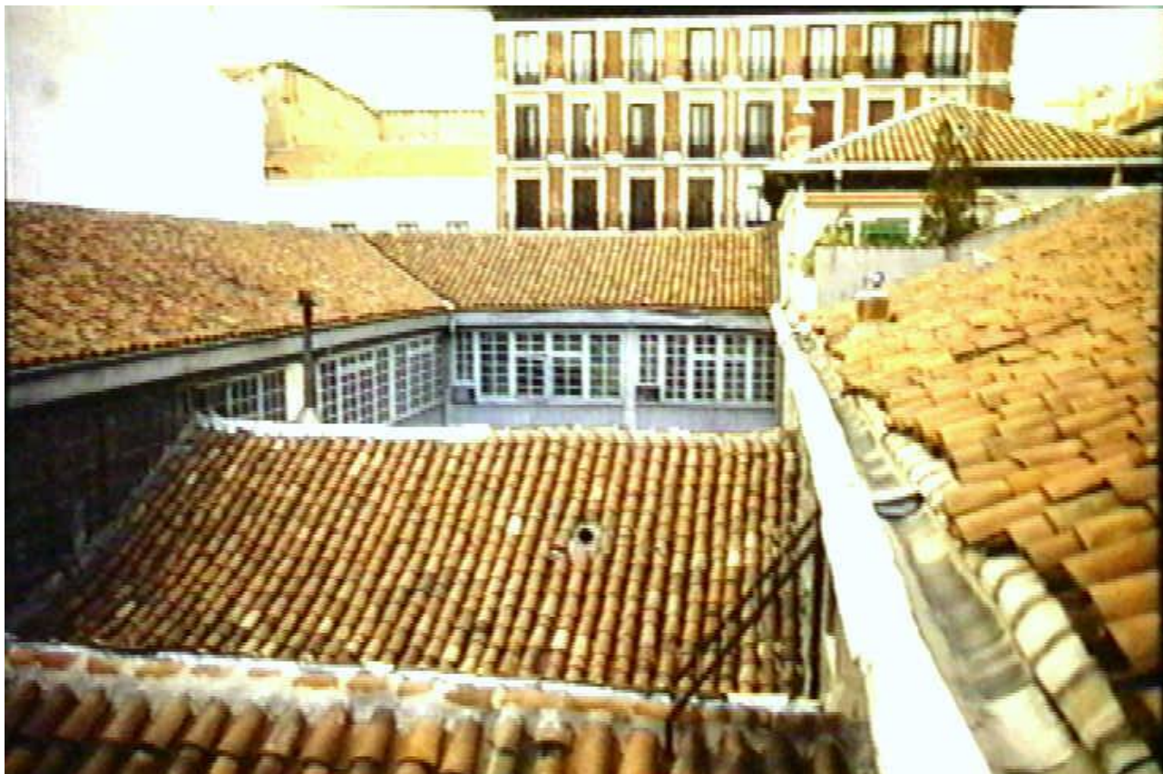
Fig. 6- Vista de las cubiertas del edificio Lamarca Hnos. donde pueden verse los talleres originales en torno al gran patio central, cerrados por galerías acristaladas para su mejor iluminación. Fotografía: Ayuntamiento de Madrid.
