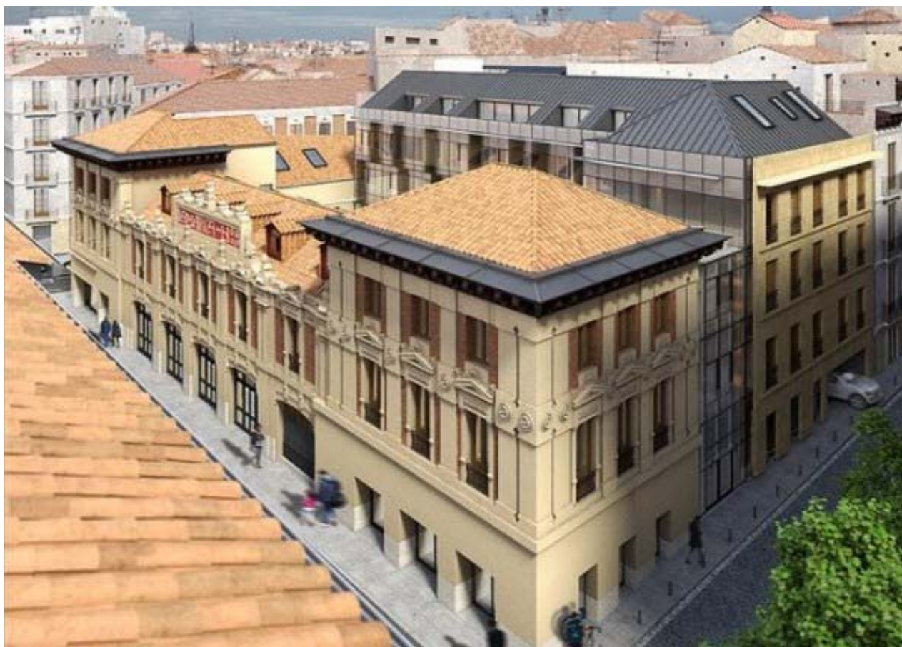
Fig. 11– Recreación infografía del proyecto residencial “Fernando VI”, que sustituye los cuerpos de talleres originales por un edificio interior en altura con fachada a la calle de Regueros. Imagen: Arata_Arquitectos - Knight Frank.
