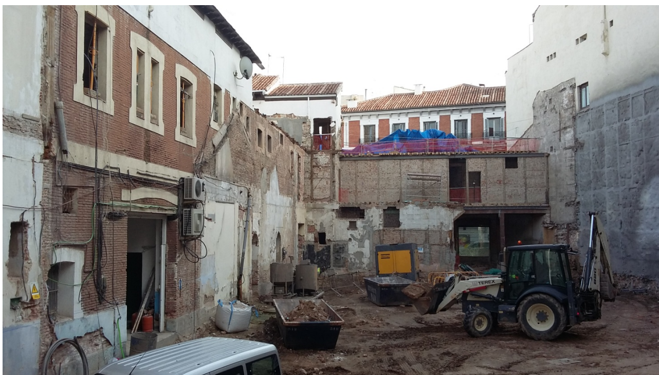
Fig. 15– El interior del edificio de Lamarca Hnos. tras su demolición, en una imagen fechada el 21 de octubre de 2015. Fotografía: VPAT.
