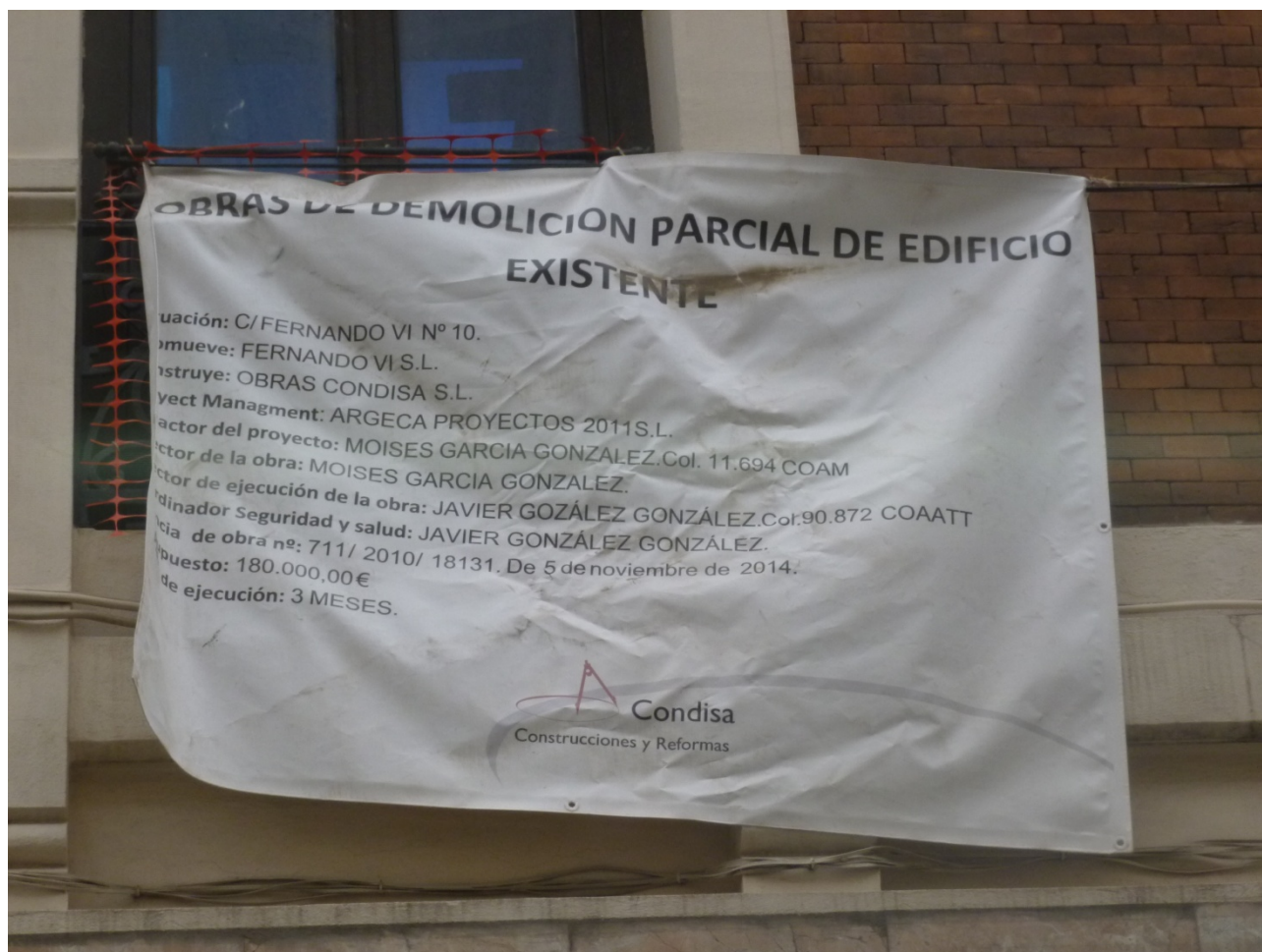
Fig. 12- Cartel con la información de las obras en ejecución, el 4 de noviembre de 2015. Fotografía: VPAT.
