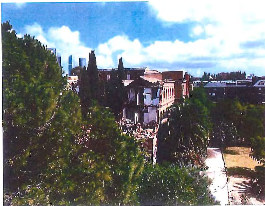
Fotografía 3. Imagen tomada desde el S de la parcela, c/ Macarena. En la imagen se puede ver la demolición parcial del convento.
