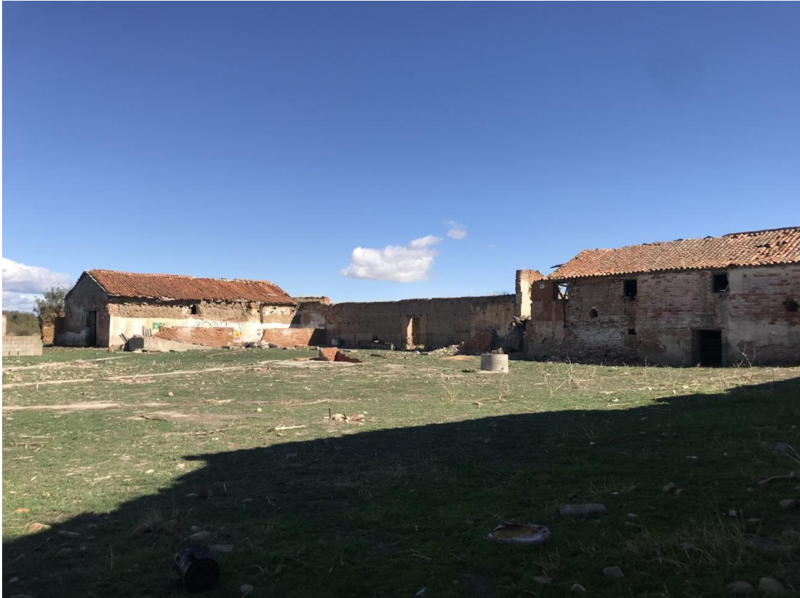
Patio interior norte del Caserío de Silillos. Daniel Sánchez García.
