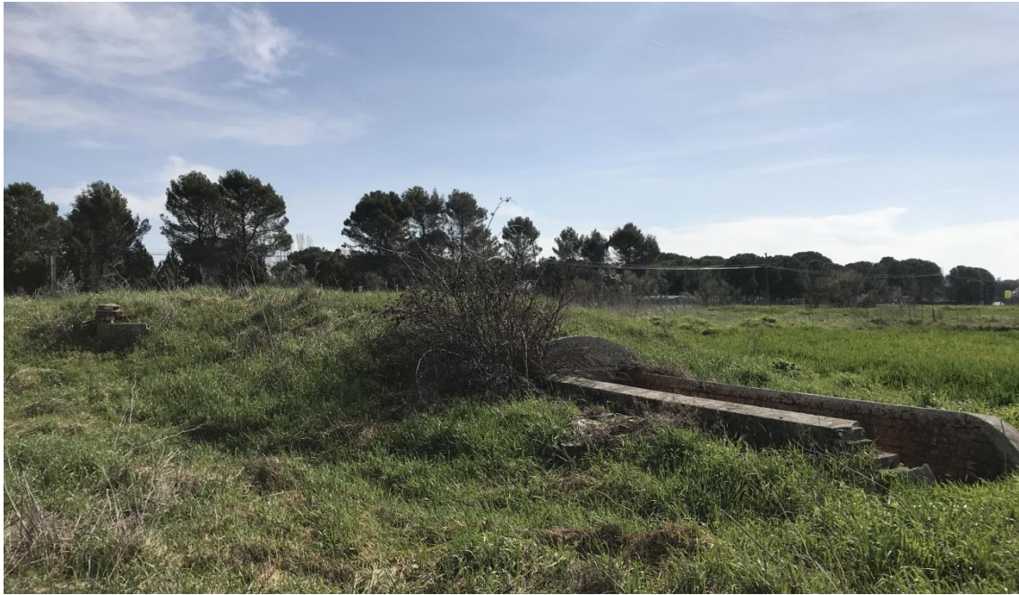
Figura 10. Imagen de la entrada sur de la galería subterránea y de un respiradero. (Daniel Sánchez García).
