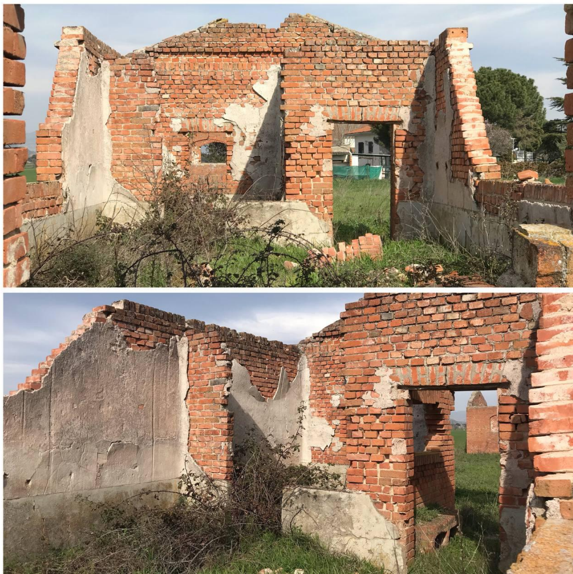
Figura 8. Imágenes del interior de la Caseta de Pilotos. (Daniel Sánchez García).
