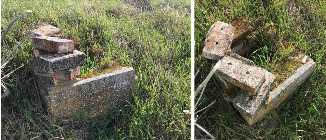
Figura 12. Imagen de uno de los respiraderos de la galería subterránea. (Daniel Sánchez García).
