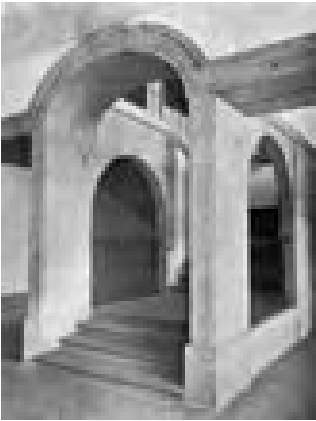
Escalera de los alojamientos reales en El Escorial. Juan de Villanueva
