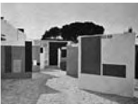
Sala de telares y botellero, alzado interior y posterior, Detalle de uno de los muros altos. Fundación Alejandro de la Sota. Muretes escalonados. Hogar y arquitectura, 1956, nº 16.
