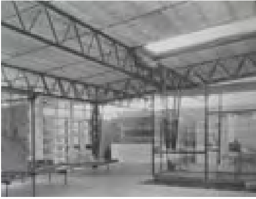
Pabellón de la Obra Sindical del Hogar, 1956. Hogar y Arquitectura, nº4, 1956.
