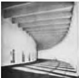
Casa de las Naciones. Interior del portico circular cubierto con vigas radiales. Wasmuths Lexicon der Baukunst, 1932. Archivo Cabrero.
