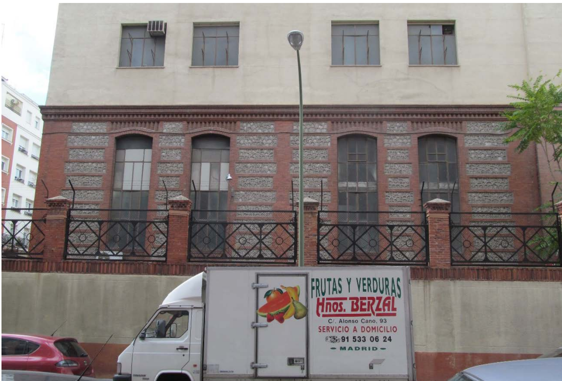
Fig.14-El Laboratorio de Analisis Químico en la actualidad visto desde la calle Modesto Lafuente. Inicialmente ampliado con una atico con mansardas (cf. figs.9 y 10) en los años 30 y 40 se le recrecen dos alturas. Foto Álvaro Valdés
