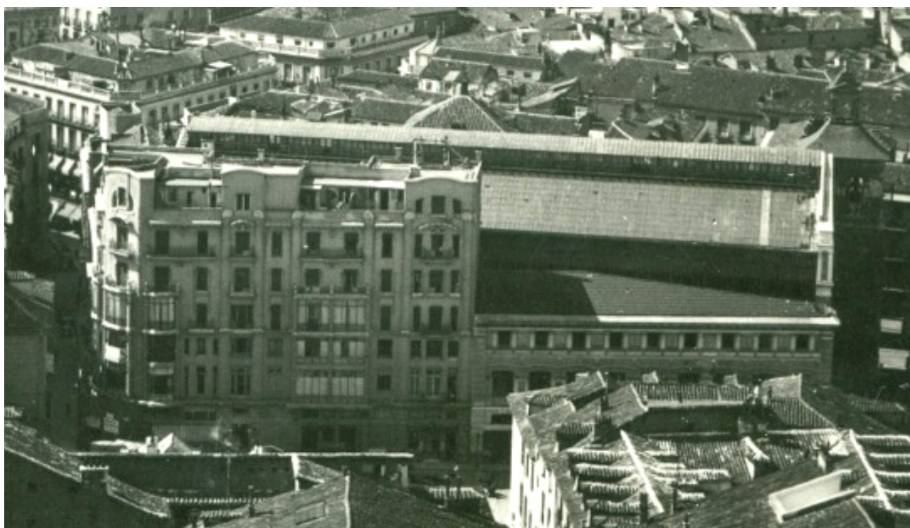
Fig. 16–Fotografía del Frontón Central tomada desde el nuevo edificio de la Telefónica en la Gran Vía, donde se aprecia la espectacular dimensión de su cubierta y la antigua fachada hacia la plaza del Carmen, idéntica a la que todavía se conserva de la calle de Tetuán. Detalle de una fotografía de Loty, hacia 1930.
