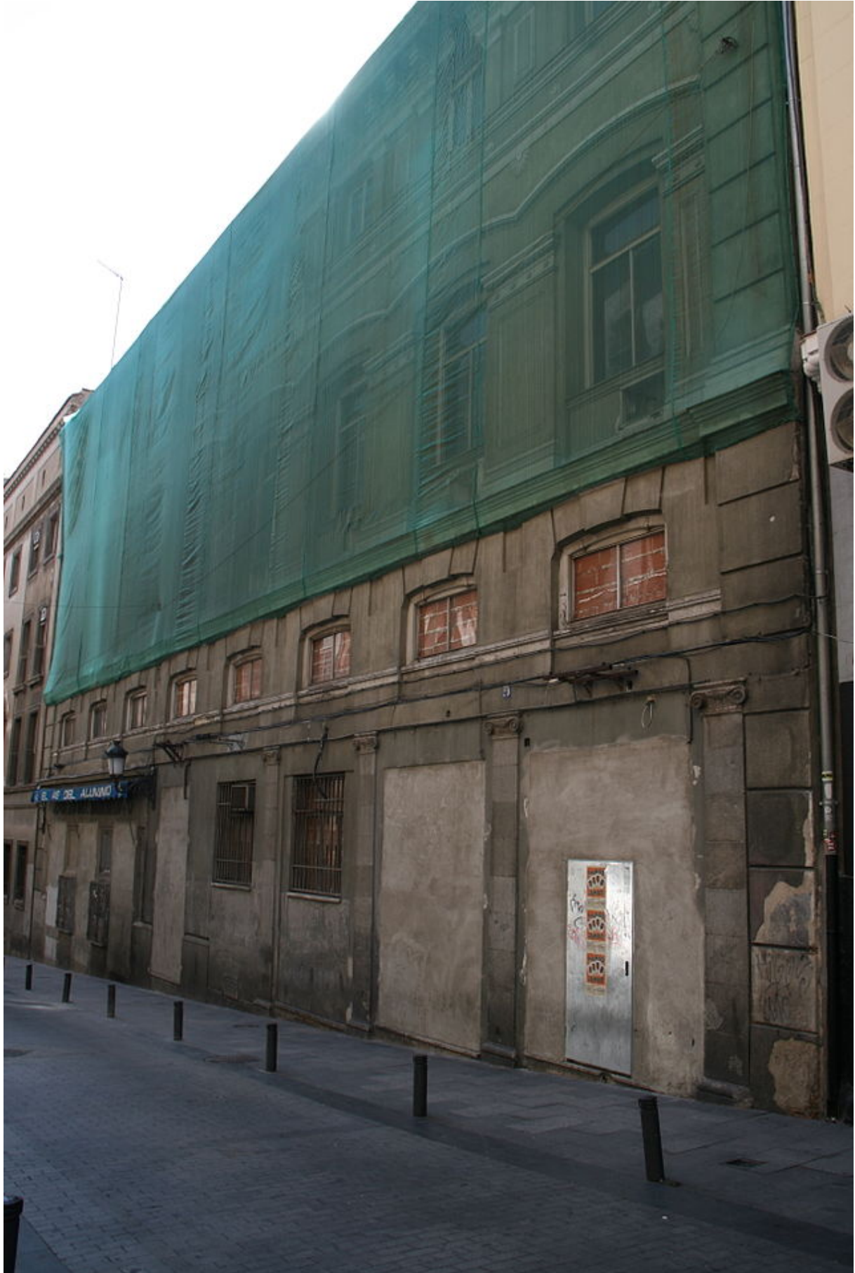
Fig. 103- Fachada del antiguo Frontón Central hacia la calle de Tetuán, que conserva la traza original que diseñó el arquitecto Daniel Zavala en 1898, excluida la planta baja.
