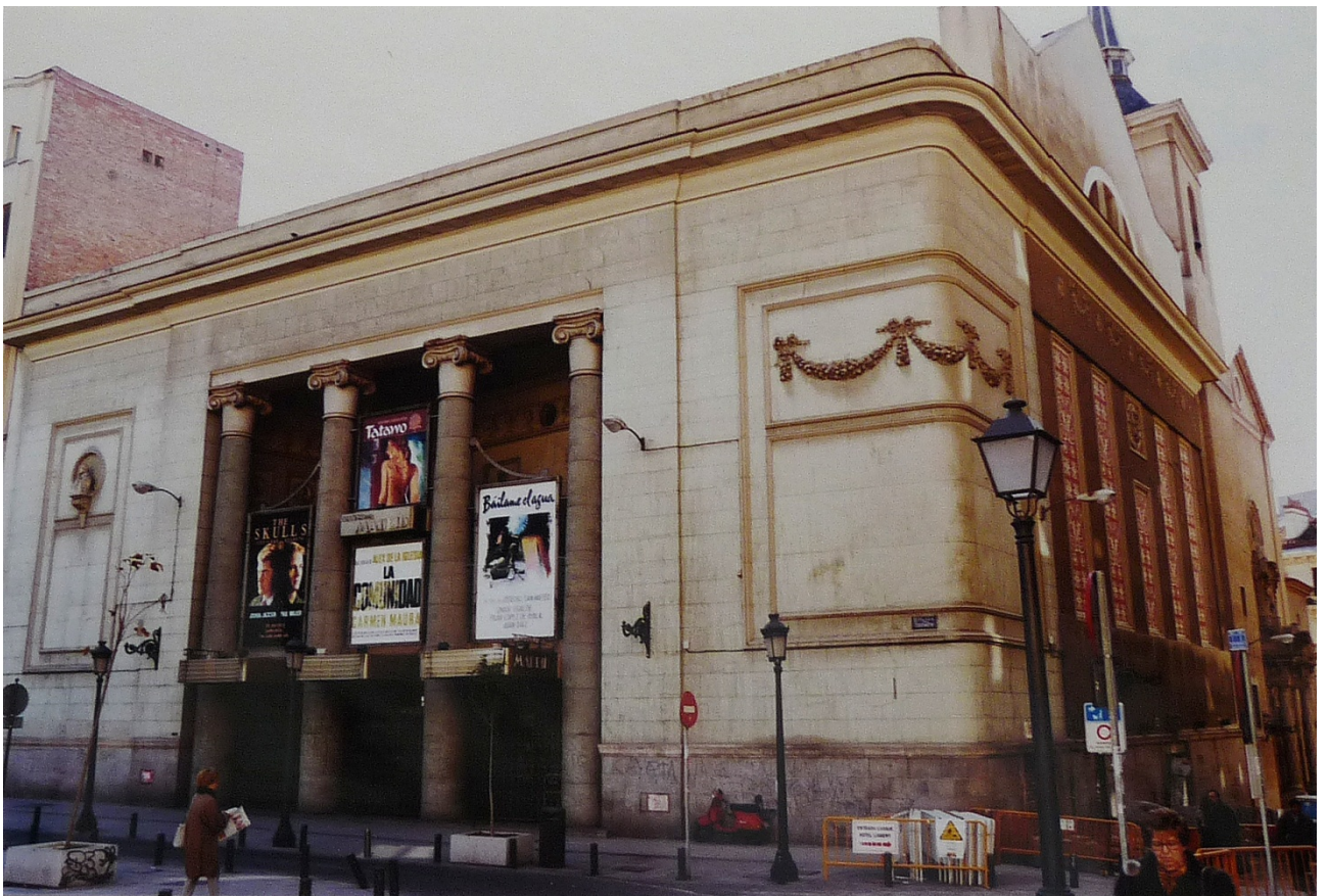
Fig. 101- Vista de los multicines Madrid desde la esquina de la plaza del Carmen con la calle de la Salud. Fotografía Servicio Histórico Fundación COAM.
