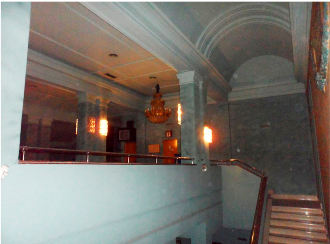
Fig. 75– Vista de la escalera con muchos elementos originales reconocibles, como las pilastras pareadas o la bóveda de cañón, todo ello conservado hasta 2014. Esta imagen procede de los documentos que obran en poder del Ayuntamiento de Madrid con los que se ha tramitado la reestructuración prevista.
