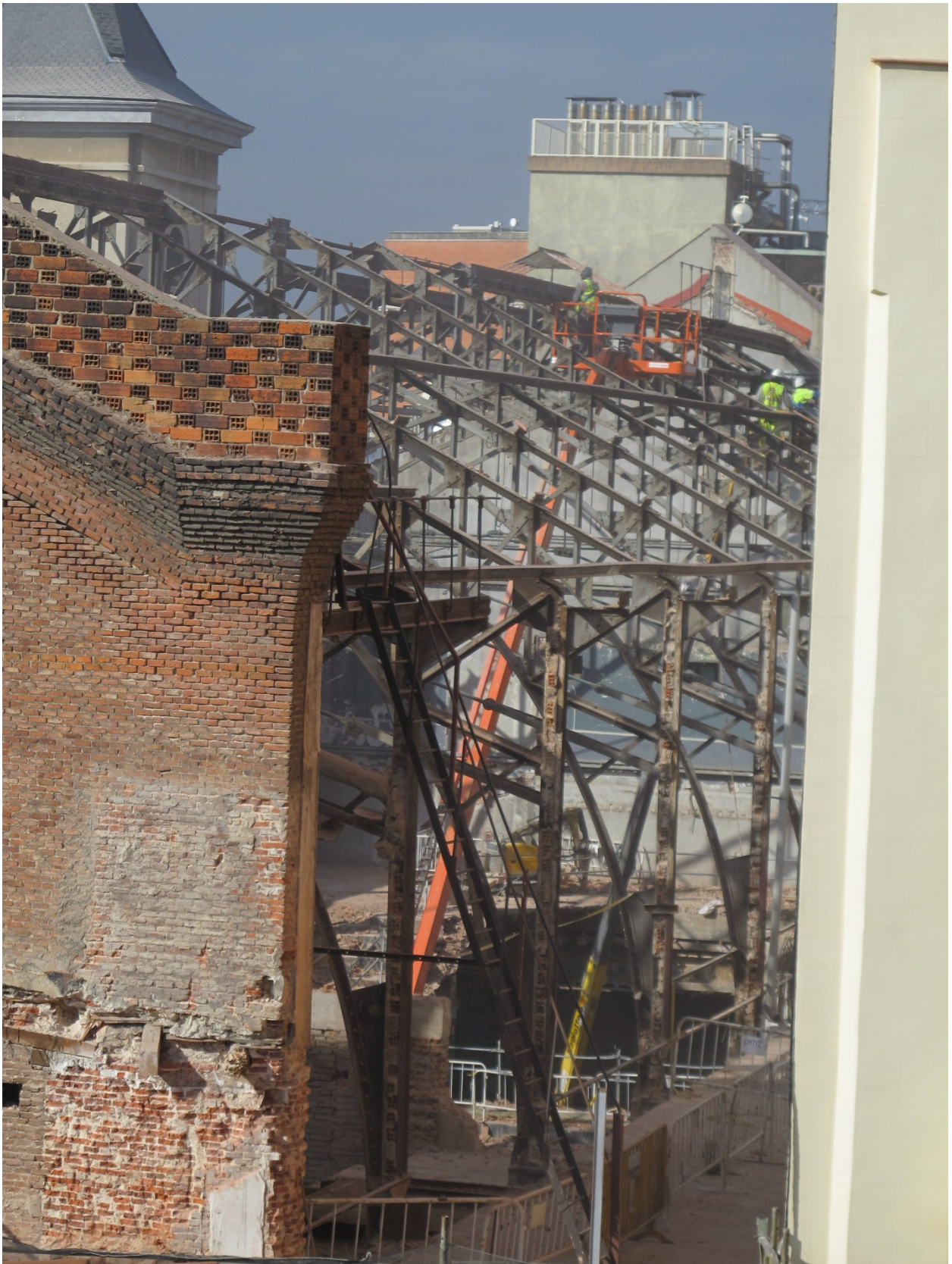
Fig. 106 - Vista de la estructura original del Frontón Central. Foto MCyP. Noviembre de 2014.
