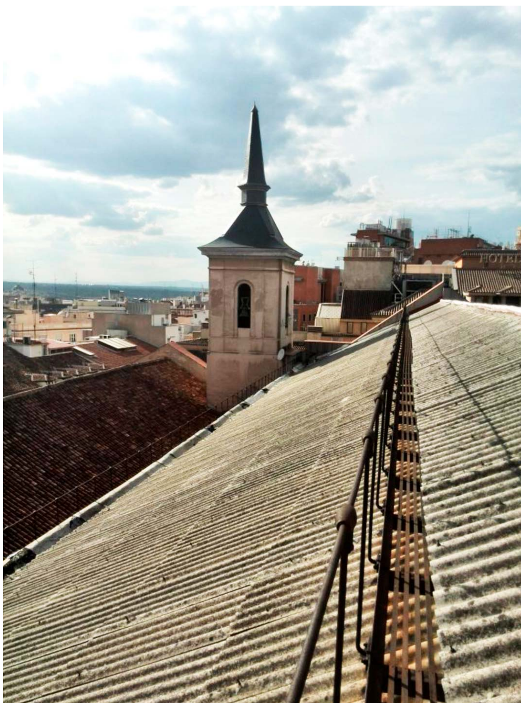
Fig. 102 - Imagen de la cubierta antes de la intervención de 2014. Foto del expediente de la licencia.
