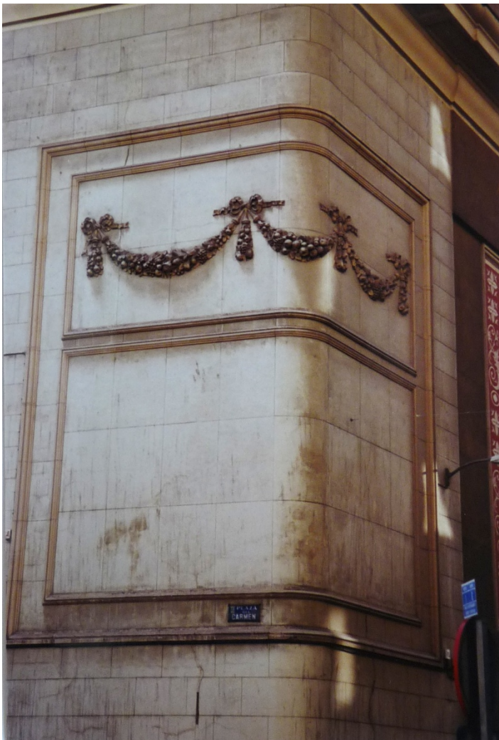
Fig. 88– Detalle de la esquina del Teatro Madrid.
