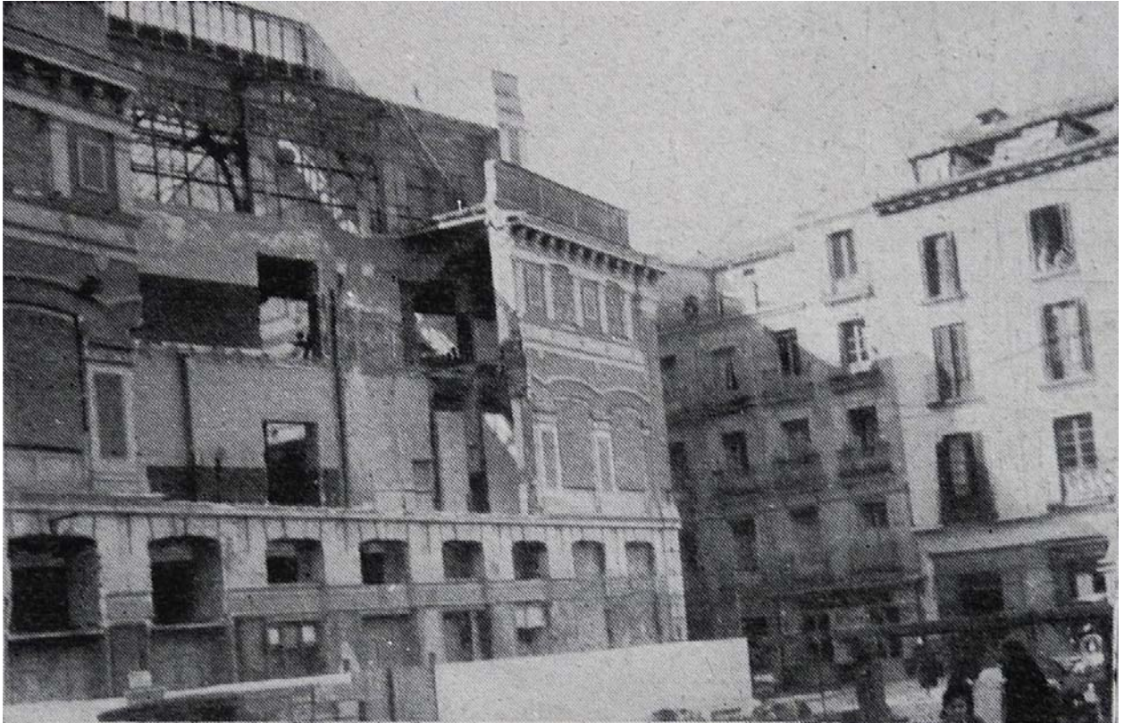
Fig. 81– Demolición de la fachada del Frontón Central hacia la plaza del Carmen, para abrir el pórtico del Teatro Madrid. Puede observarse como se conserva la estructura metálica de la cubierta original. Fotografía publicada en la Revista Nacional de Arquitectura . Año IV, nº 27, marzo de 1944.
