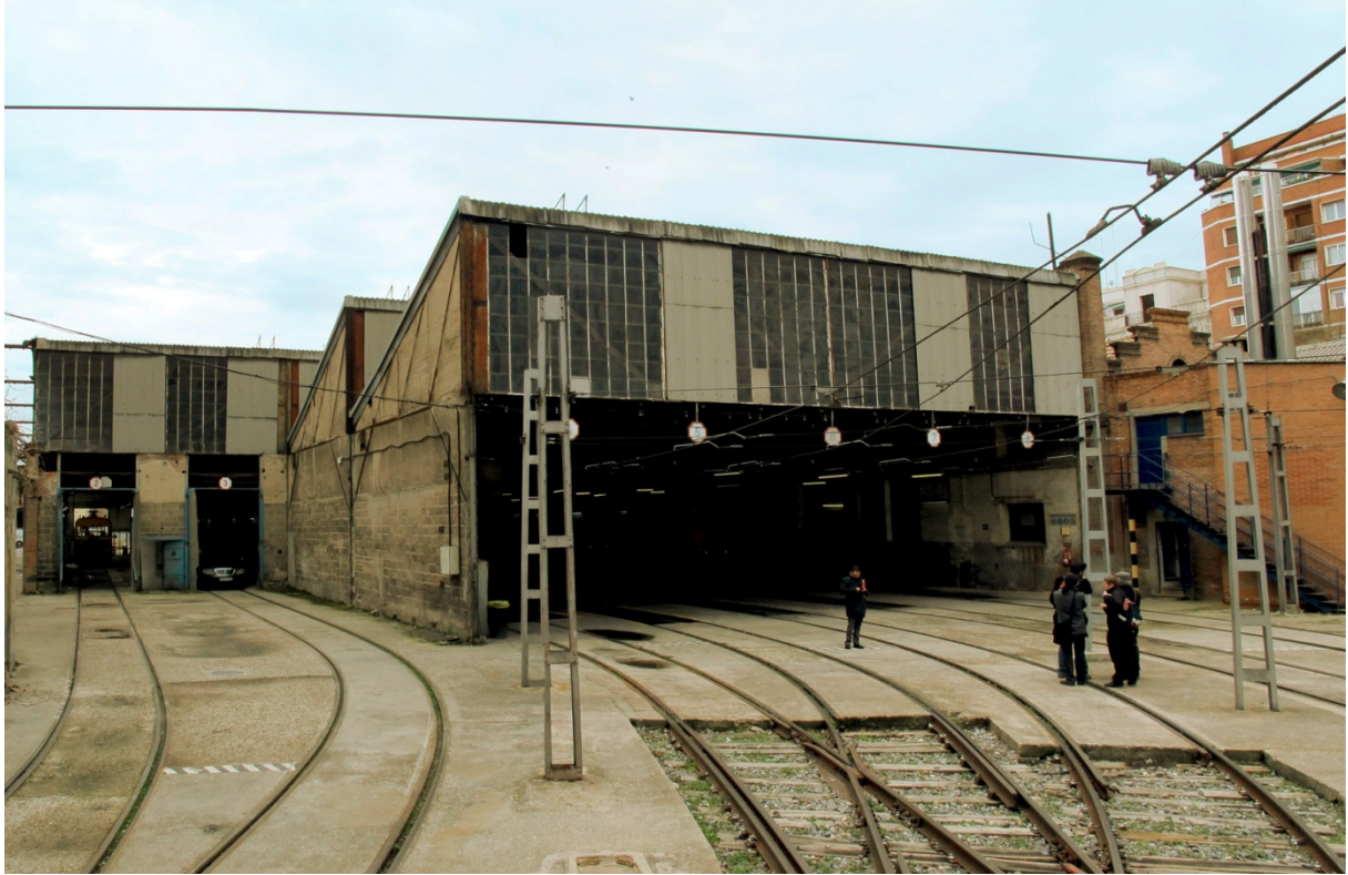
Vista de las naves originales (1919) de las Cocheras de Cuatro Caminos de Metro. Foto MCyP, 2015.
