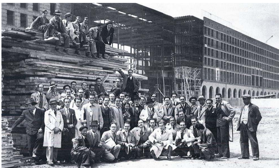
Secundino Zuazo (en el centro) rodeado por un grupo de arquitectos durante una visita girada en 1935 a las obras de los Nuevos Ministerios.
